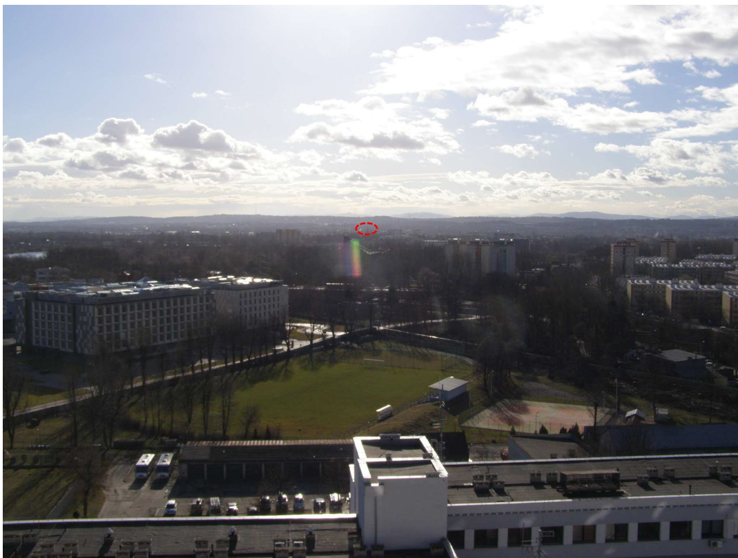
Rysunek 10. Węzeł KWP Kraków, ul. Mogilska 109 – kier. Komisariat Policji VI, Kraków, ul. Ćwiklińskiej 4 – zdjęcie wykonane z poziomu dachu środkowej nadbudówki
