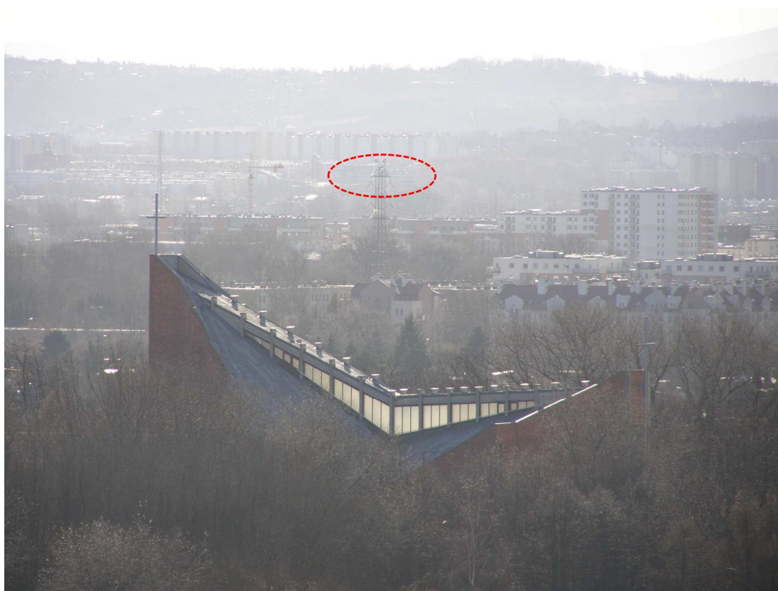
Rysunek 11. Węzeł KWP Kraków, ul. Mogilska 109 – kier. Komisariat Policji VI, Kraków, ul. Ćwiklińskiej 4 – zdjęcie wykonane z poziomu dachu środkowej nadbudówki z zoomem x10
