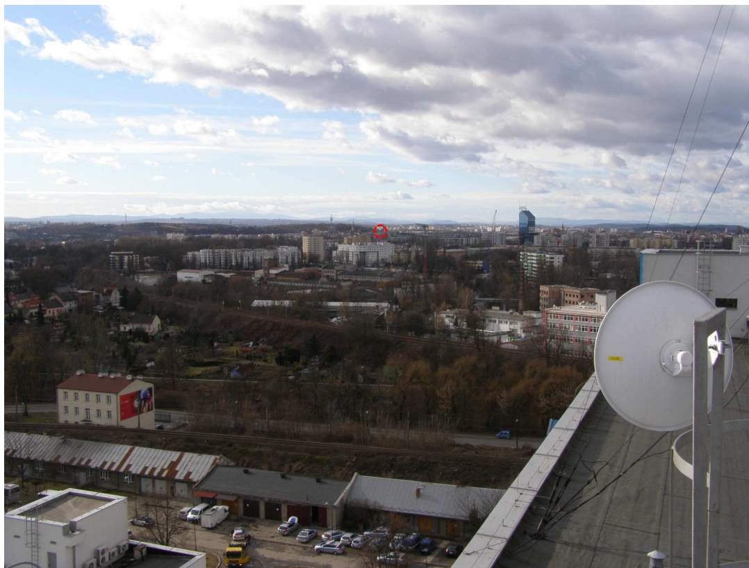
Rysunek 17. Węzeł KWP Kraków, ul. Mogilska 109 – kier. Komisariat Policji V, Kraków, ul. Zamoyskiego 22 – zdjęcie wykonane z poziomu dachu środkowej nadbudówki
