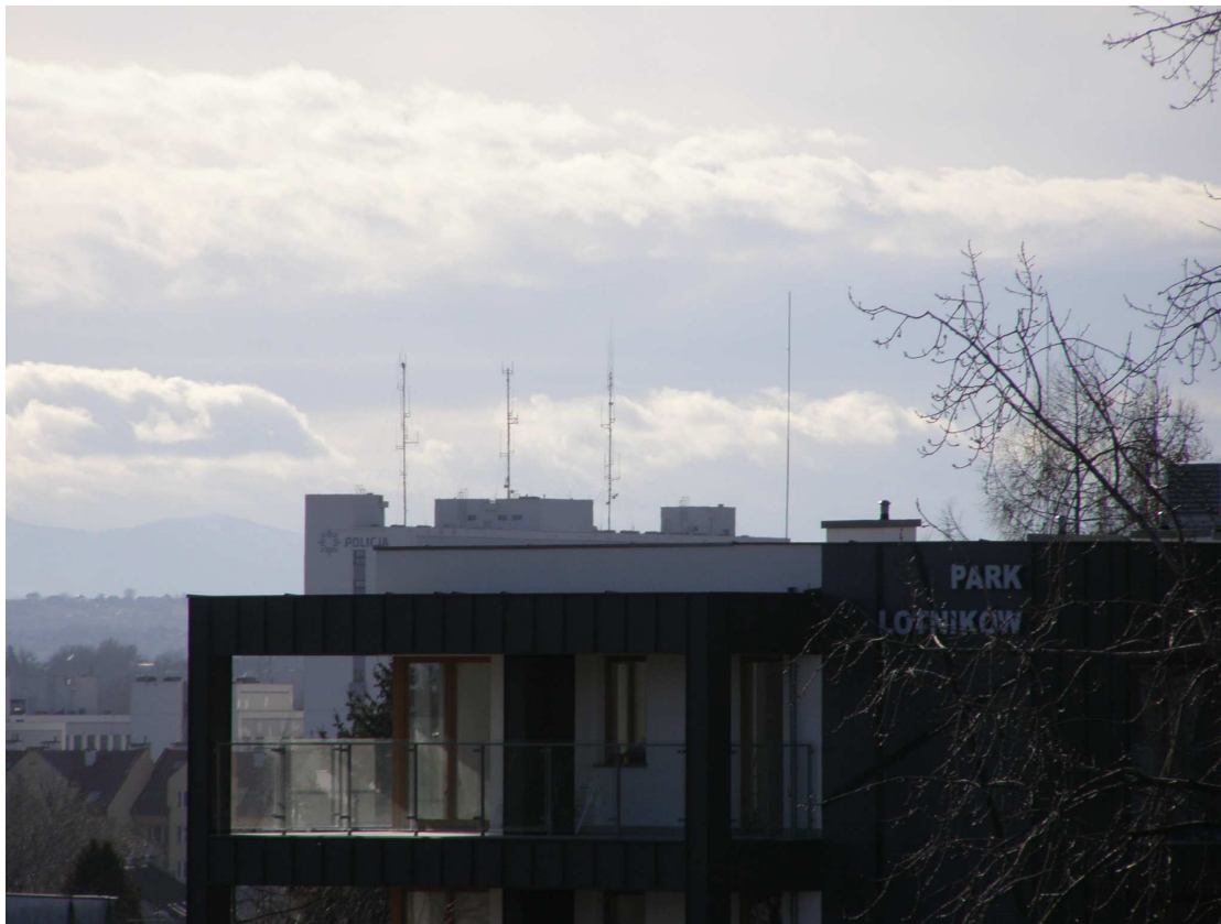
Rysunek 7. Węzeł Muzeum Lotnictwa, Al. Jana Pawła II 39 – budynek główny – kier. KWP Kraków, ul. Mogilska 109 – zdjęcie wykonane z poziomu dachu z zoomem x10
