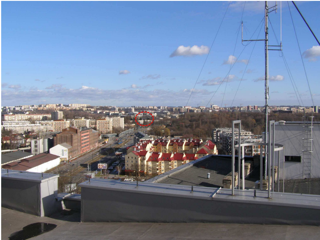
Rysunek 3. Węzeł KWP Kraków, ul. Mogilska 109 – kier. Muzeum Lotnictwa, Al. Jana Pawła II 39 – budynek główny – zdjęcie wykonane z poziomu dachu środkowej nadbudówki
